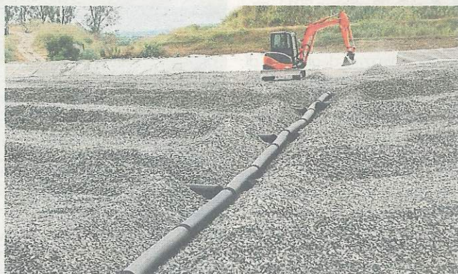
Le nuove vasche in corso di realizzazione nella discarica di Torretta
