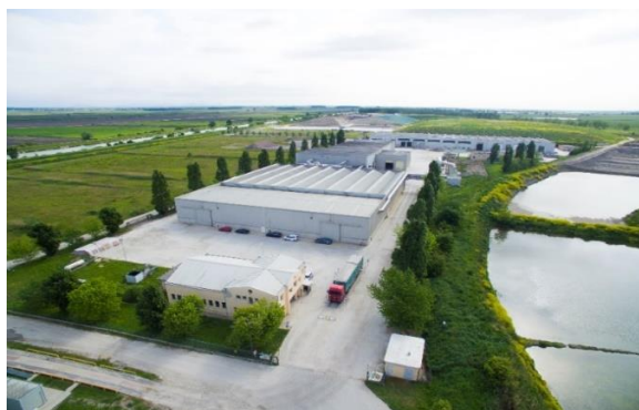
Ingresso al Sistema Integrato di Smaltimento di Torretta in gestione a Legnago Servizi S.p.A..
