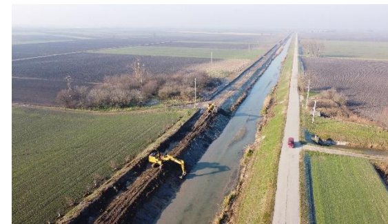
Lavori di sistemazione idraulica in corso sulla Fossa Maestra.
