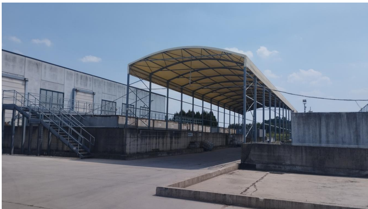
Foto 4 area stoccaggio percolato
