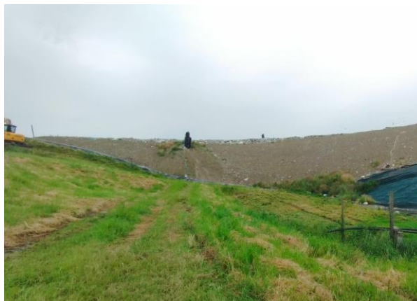
Foto 7 vasca C, vista da Est
